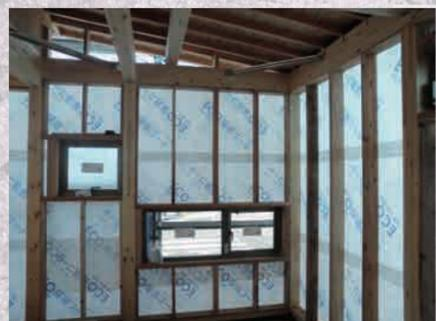
建前が終わってからは、外部周りの工事を優先して行っていきます。屋根には断熱材を敷き詰め、通気層を作って、ガルバニウム鋼板の屋根材を張っていきます。(^^°)壁は下地を起こして、サッシを取り付け、透湿防水シートを張っていきます。ベランダは水が流れるように勾配をつけ、FRPの防水を行いました。ここまですれば、雨が降っても大丈夫！住宅瑕疵保険の構造検査・外装下地検査も無事終わり、外部の残り工事と内部の工事へと進んでいきます。だいぶ暖かくなり、日も長くなって来たので、仕事がはかどりそうです。(^^°)
