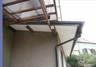
屋根が傷んで雨漏りしていたので、下地を直し、新しくガルバニウム鋼板の屋根に葺き替え工事をさせて頂きました。軒下も傷んでいたため、傷みにくく、防火性能のあるケイカル板に張り替えました。屋根は普段、なかなか点検する事はできないので、耐久性の高い材料を使うことがおすすめです。(^▽^\*)
