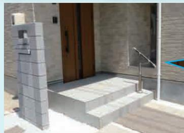
玄関ポーチの段差を上り下りする時に手摺が欲しいとの依頼で、手摺を設置させて頂きました。高さと角度を使う方に合わせて、自由に変えられることができます。手摺があると、段差がとっても楽に、そして安全に昇り降りできますね(\*^▽^\*)
