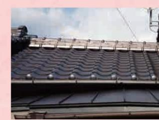
屋根のブリキ部分と庇の老朽化のため、改修工事をさせて頂きました。
