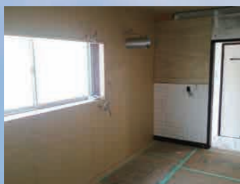
③ 下地施工
